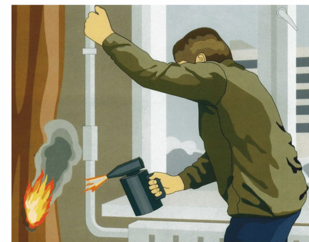
Отогревание замерзших труб паяльными лампами и факелами
